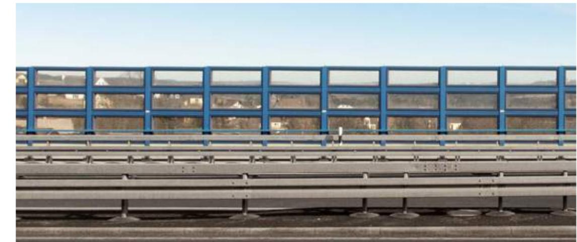
// **KOHLHAUER** zeigt sein exzellentes technisches Verständnis durch rahmenlose transparente Elemente mit Punkthalter-Befestigungen.
