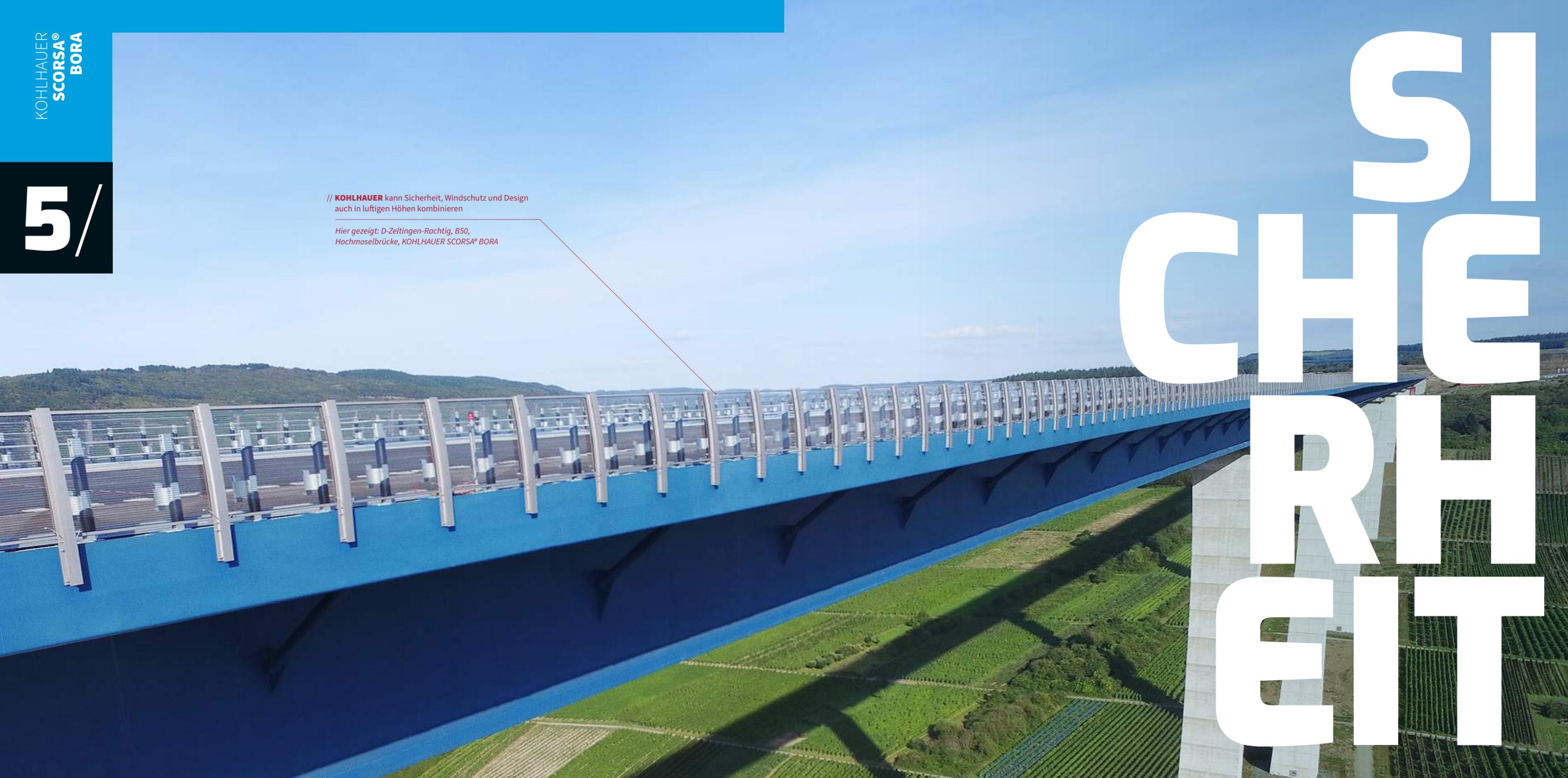
**Windlasten** zählen zu den klimatisch veränderlichen Einwirkungen auf Bauwerke. Sie ergeben sich aus der Druckverteilung um ein Bauwerk, welches starker Windströmung ausgesetzt ist. Dazu gehören zahlreiche Brücken in zum Teil sehr exponierten Lagen, z. B. über Tälern. Stürme, Windböen oder Seitenwind stellen bei entsprechender Stärke eine große Gefahr für Verkehrsteilnehmer dar.
