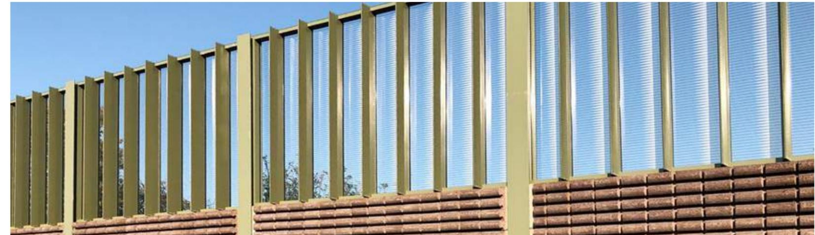
**Gegossenes Acrylglas GS** besitzt eine hervorragende Oberflächenqualität. Es ist jahrelang witterungs- und alterungsbeständig, vergilbt nicht und wird nicht rau. Das Material wird hergestellt, indem die Grundstoffe in eine Form gegossen oder beispielsweise zwischen zwei Spiegelglasplatten zusammengebracht werden.
