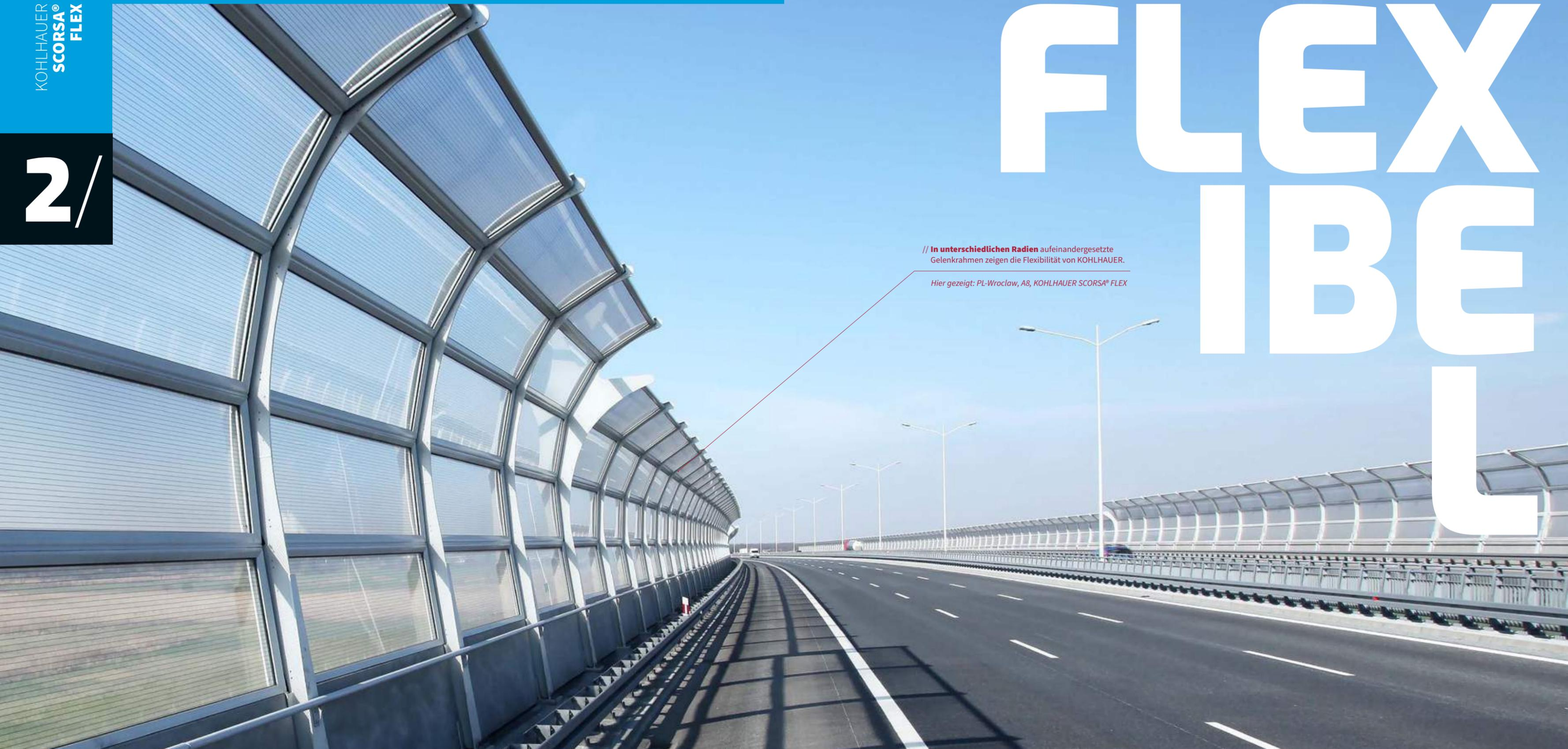
Mit dem SCORSA® FLEX-System können transparente Rahmensysteme nun auch an gebogenen Lärmschutzwänden eingesetzt werden. Sie erlauben eine bessere Lärmdämpfung bei gleichzeitiger Wandhöhenreduzierung. Das KOHLHAUER SCORSA® FLEX-System bietet dazu die Lösung: von der Stütze über den flexiblen Gelenkrahmen bis zur Befestigung durch eine spezielle Klemmkonstruktion. Die unkomplizierte und schnelle Installation sichert zudem exzellente Wirtschaftlichkeit.
