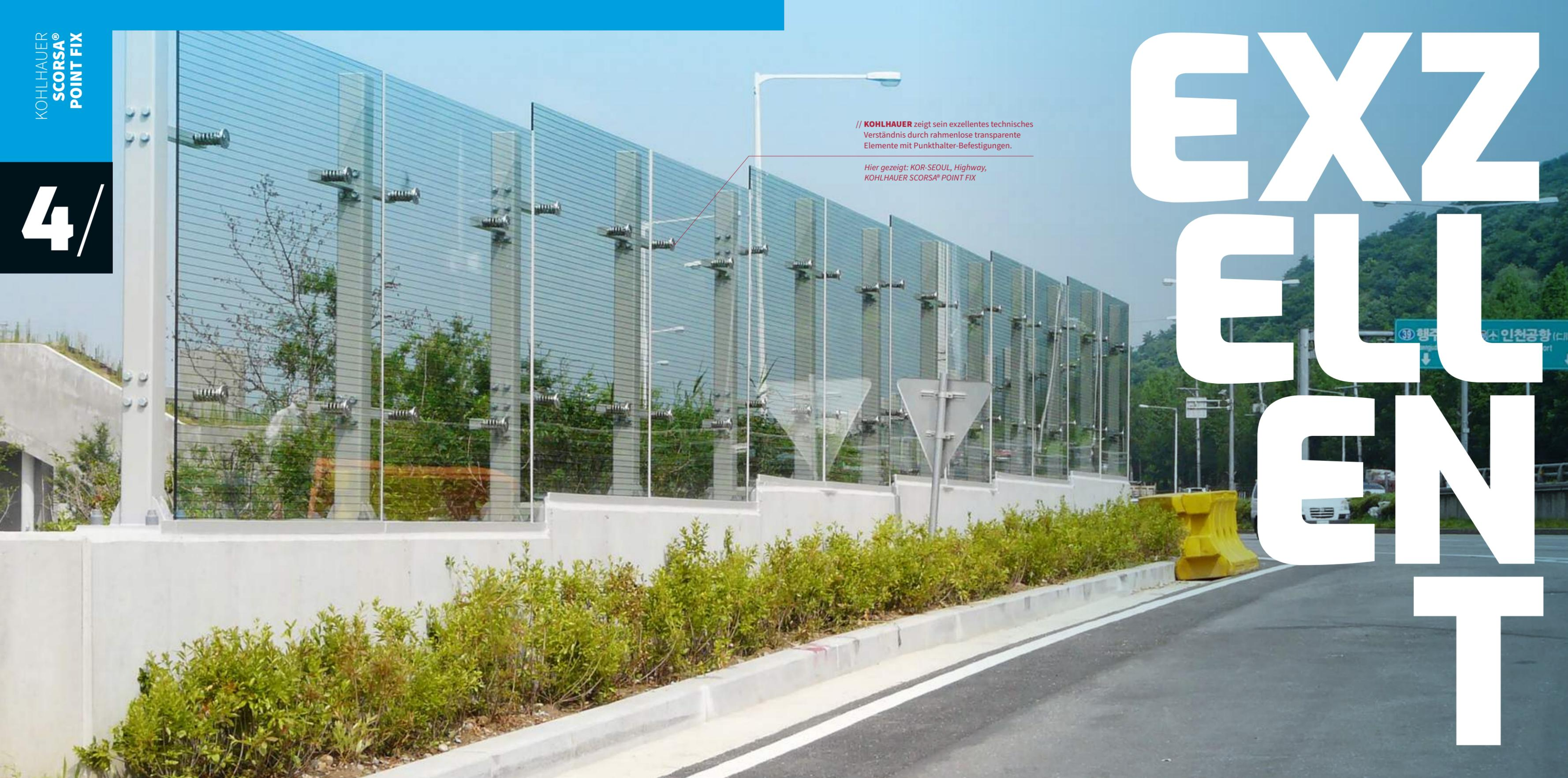
**Die Fixierung** transparenter Lärmschutz-Elemente über Ankerpunkte ist eine innovative Spitzenlösung von KOHLHAUER. Die patentierte und nachgewiesene wirkungsvolle Technik verbindet transparente Elemente elastisch über Federelemente mit einer schlanken Stützstruktur.
