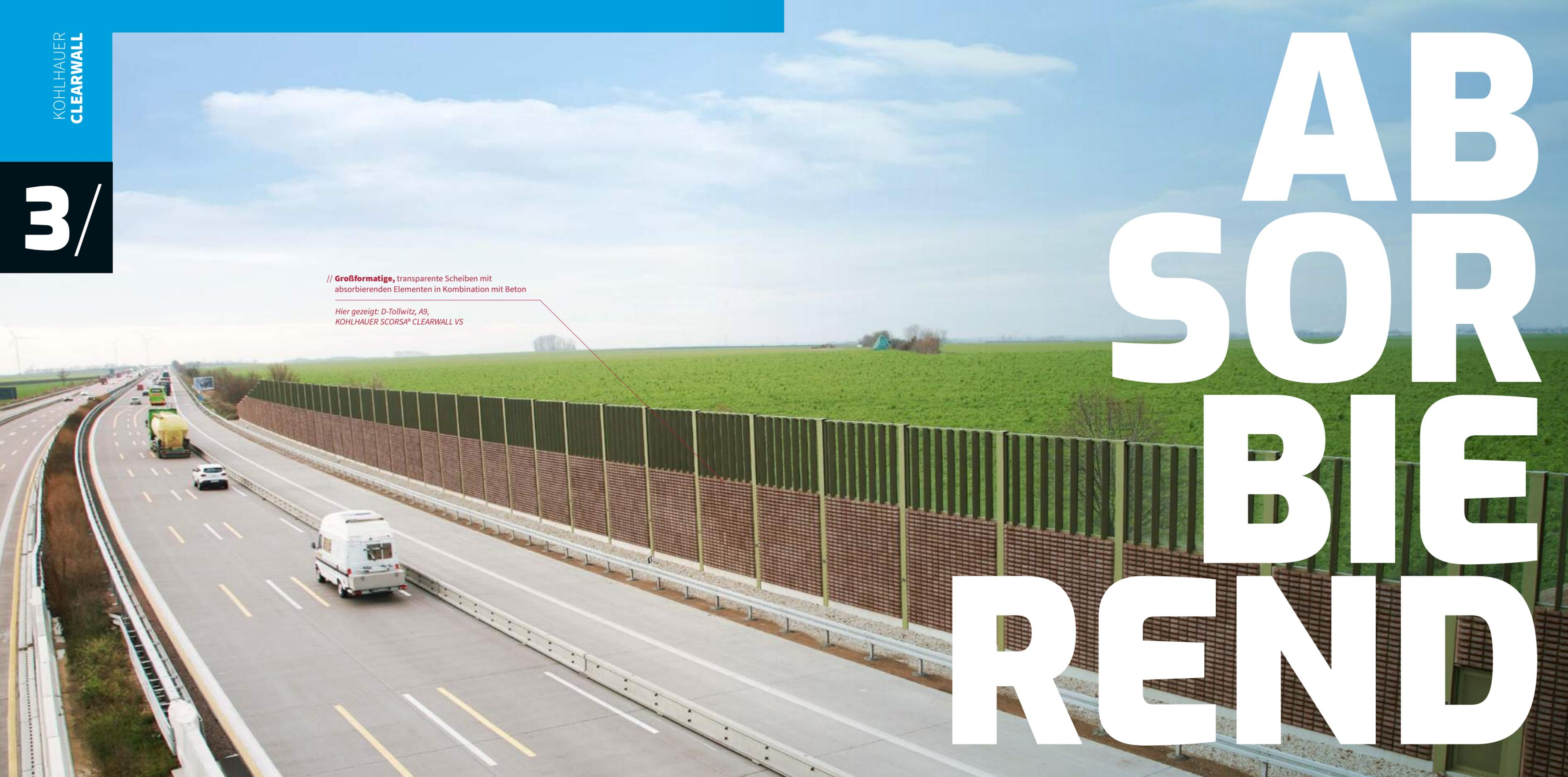
**CLEARWALL®** ist ein modulares Rahmensystem, das transparenten Lärmschutz mit integrierten absorbierenden Elementen vereint. Je nach Ausführung können Absorptionswerte von 4–8 dB erzielt werden. Es ist damit nicht mehr notwendig, auf transparente Materialien zu verzichten, wenn Schallabsorption erforderlich ist. Der freie Blick auf die Landschaft bleibt auf diese Weise erhalten, die Wahrnehmung der Lärmschutzwand als optische Barriere wird reduziert.
