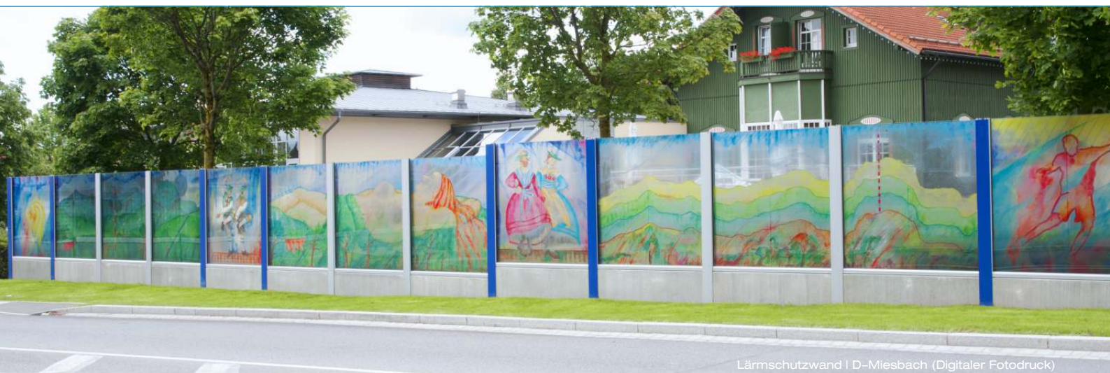
Lärmschutzwand | D-Miesbach (Digitaler Fotodruck)
