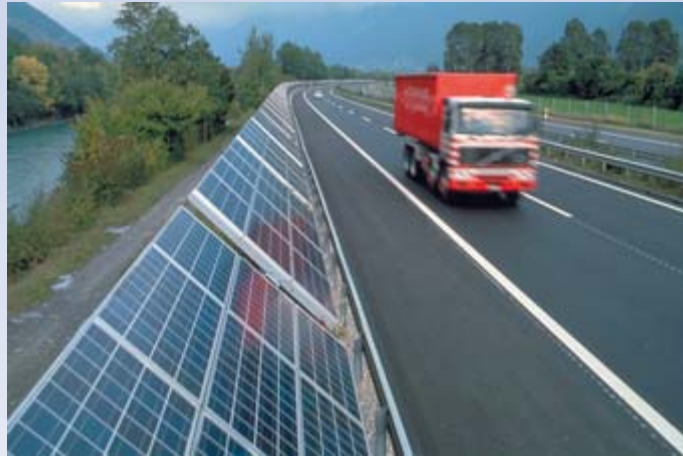
Bild 2: Weltweit erste Lärmschutzwand mit Photovoltaik Foto: TNC AG
