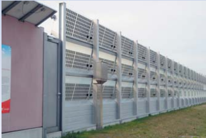
Bild 4: In Lärmschutzwand vollintegrierte Solarmodule Foto: Innovationsgemeinschaft Lärmschutz
