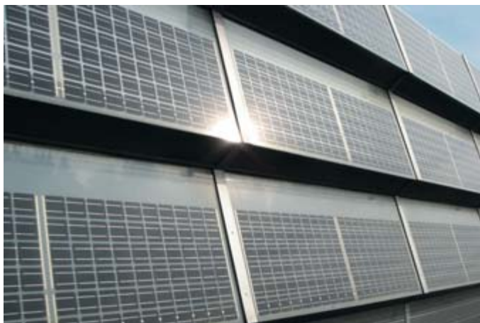
Bild 5: Auch ästhetisch ein Highlight – Lärmschutzwand mit Photovoltaikerelementen Foto: Innovationsgemeinschaft Lärmschutz
