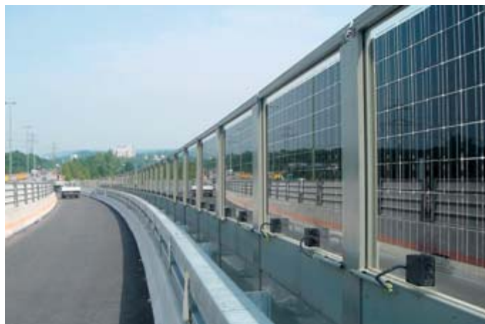
Bild 3: Bifaciale PV-Lärmschutzwand für Nord-Südrichtung Foto: TNC AG
