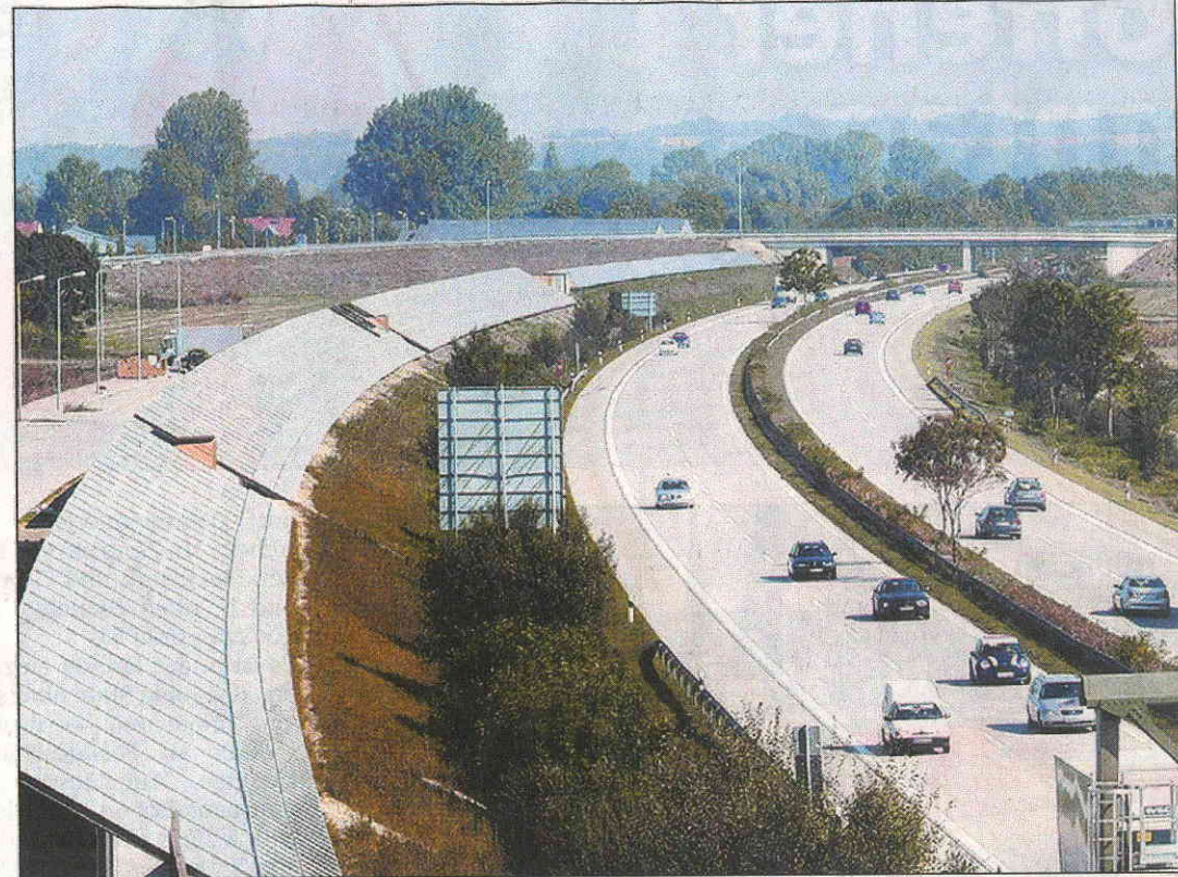
REFERENZOBJEKT: An der Autobahn bei Freising in Bayern wurde die laut Firmenangaben weltgrößte Fotovoltaik-Lärmschutz-Kombination gebaut. Fotos (2): pr
